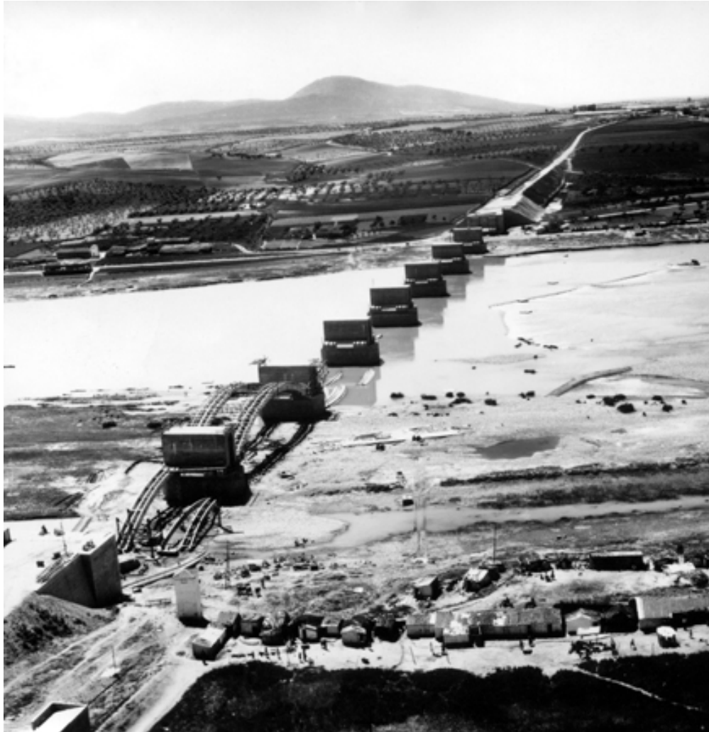
Vista aérea del puente en construcción
