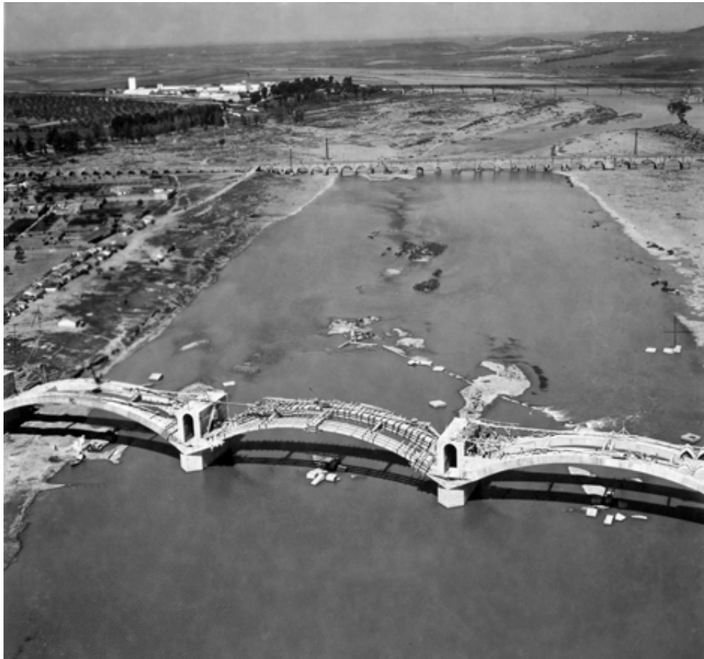
Vista aérea del puente en construcción
