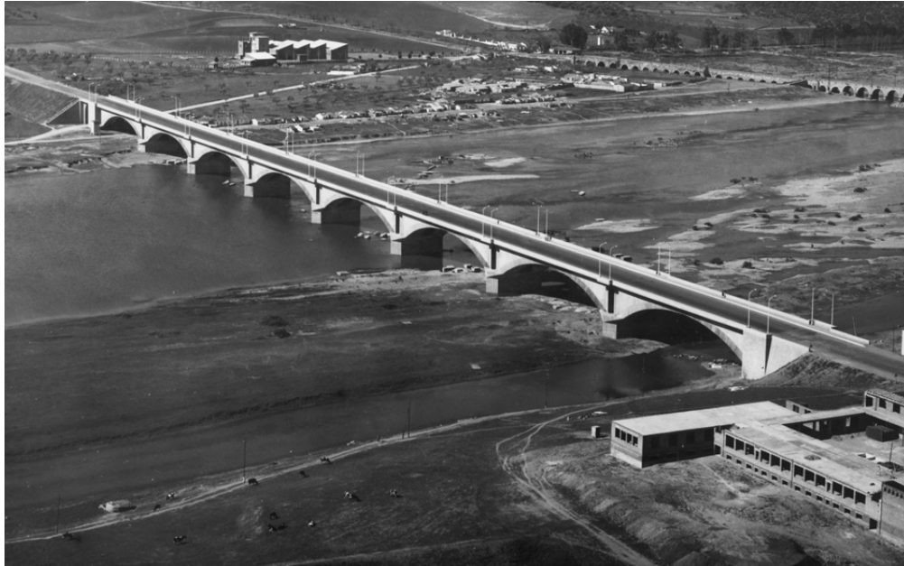
Vista aérea del puente
