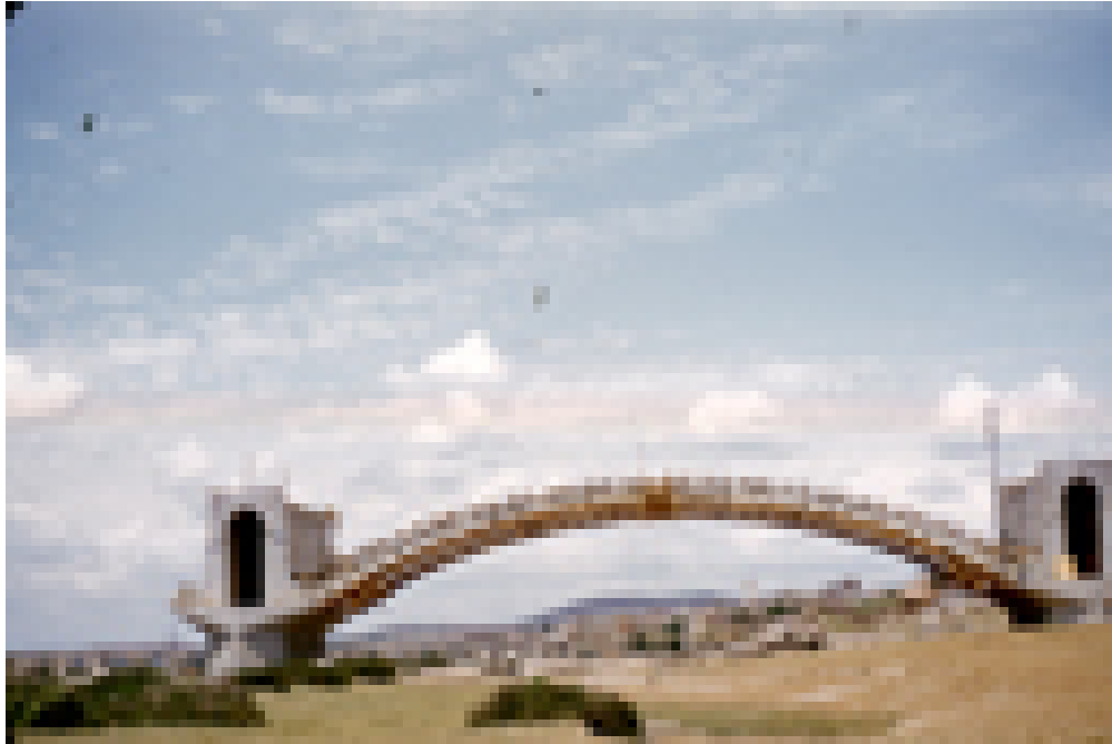
Detalle del puente en construcción
