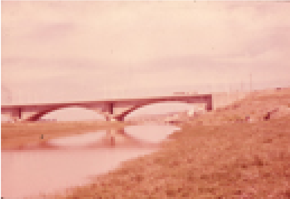
Vista del puente
