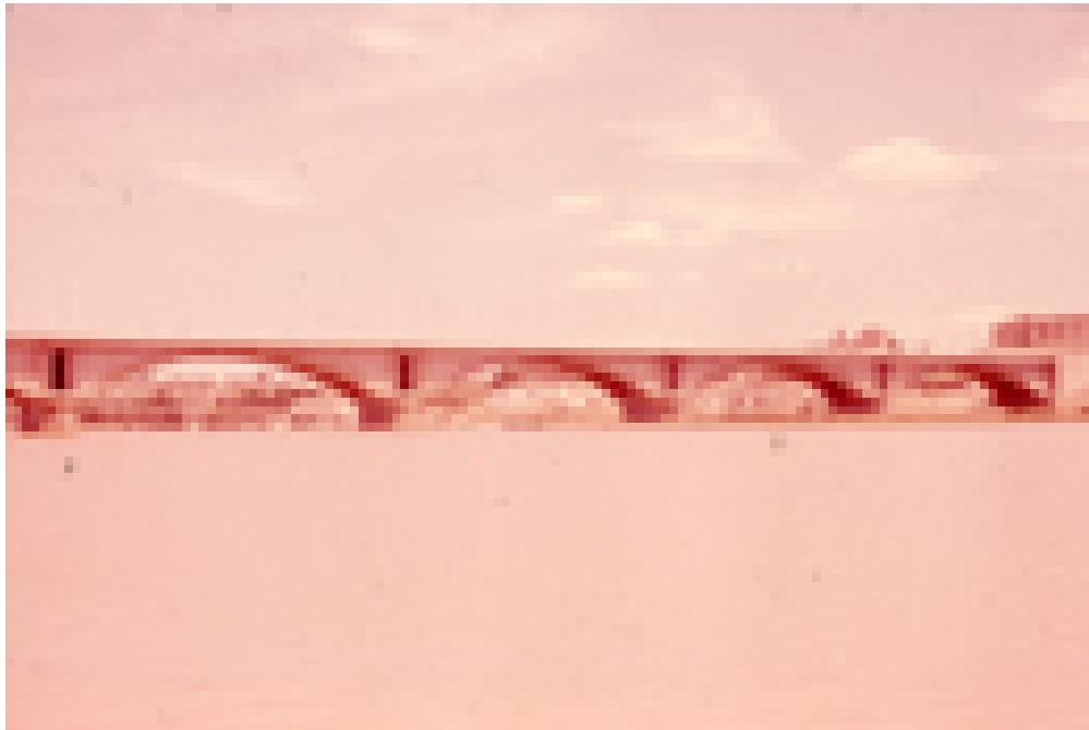
Vista del puente
