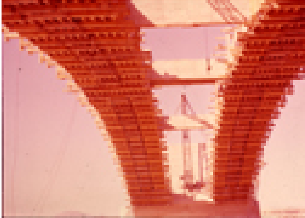
Detalle del puente en construcción
