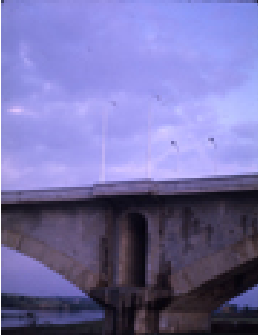
Detalle del puente
