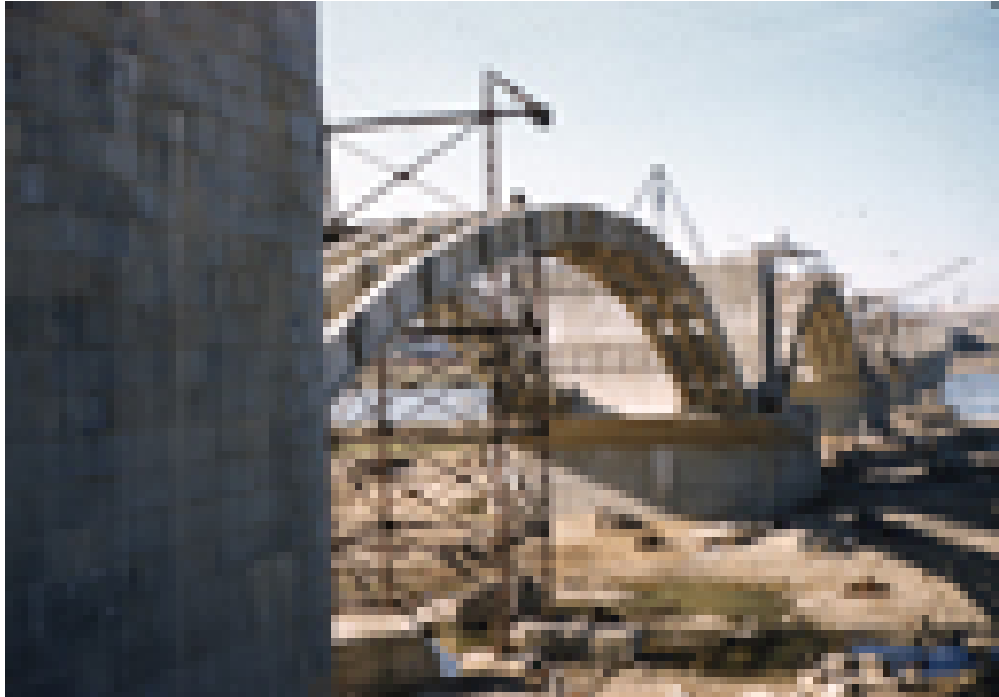
Detalle del puente en construcción
