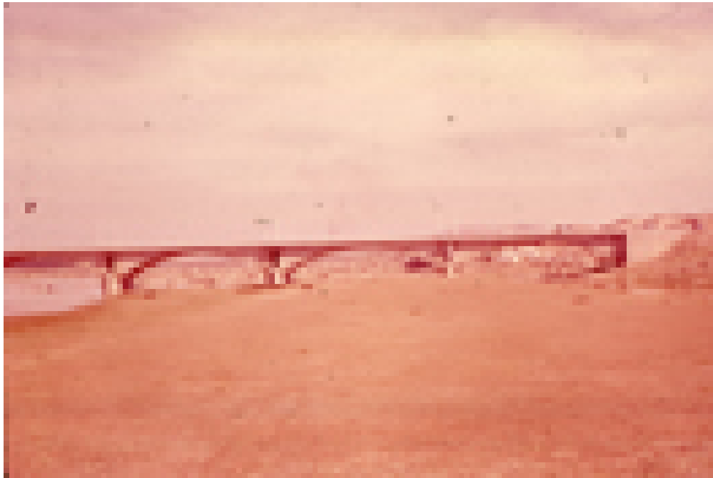
Vista del puente
