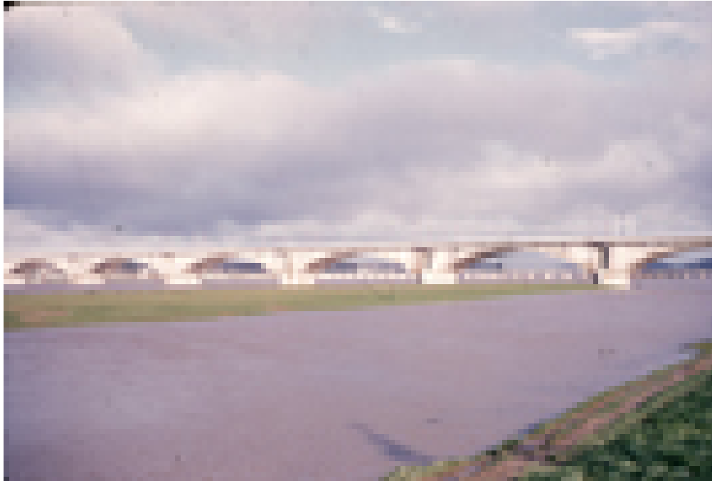
Vista del puente
