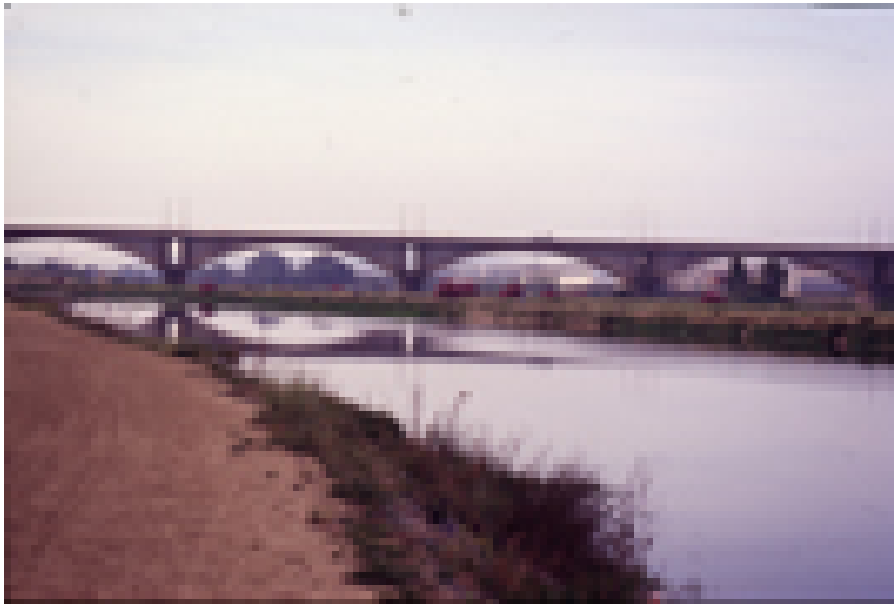
Vista del puente
