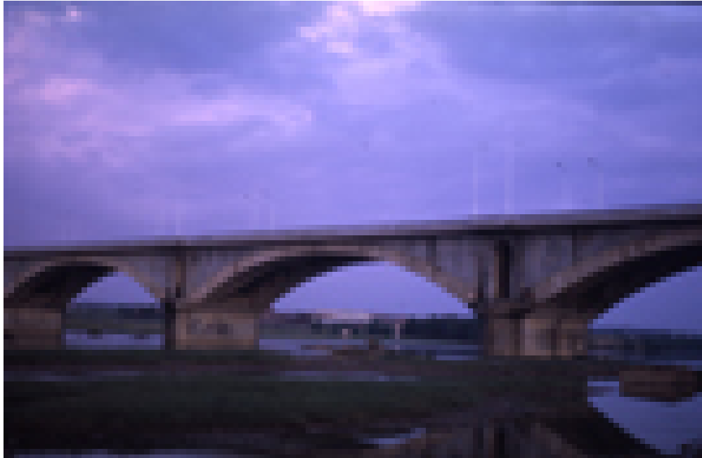
Vista del puente
