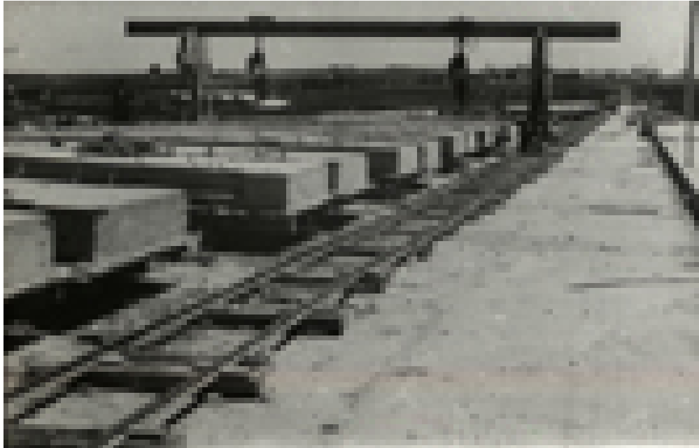
Detalle del puente en construcción
