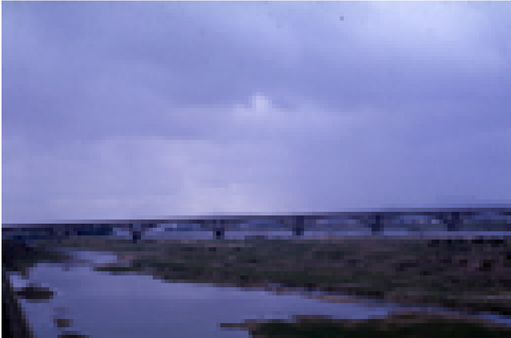
Vista del puente
