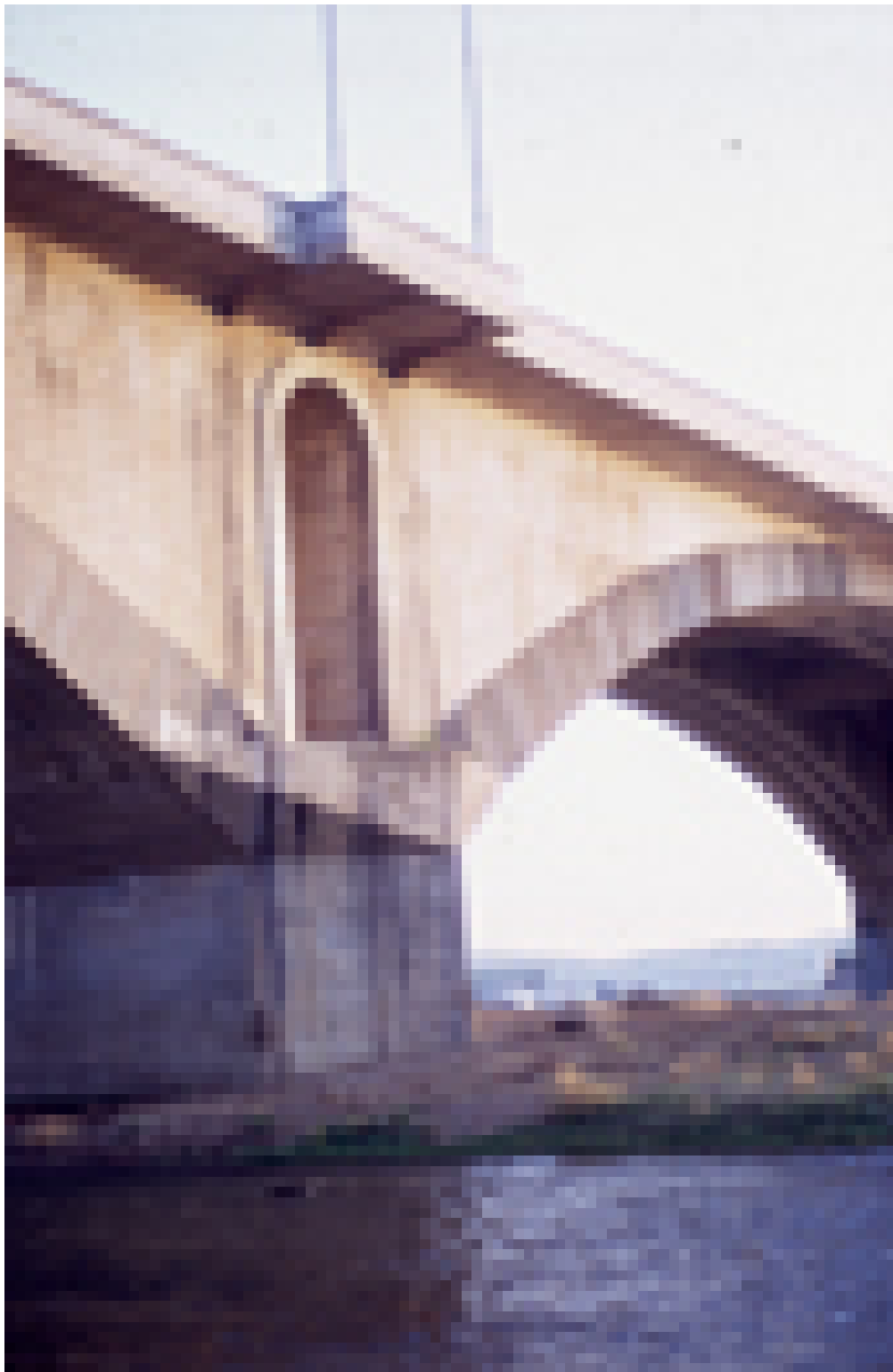
Detalle del puente
