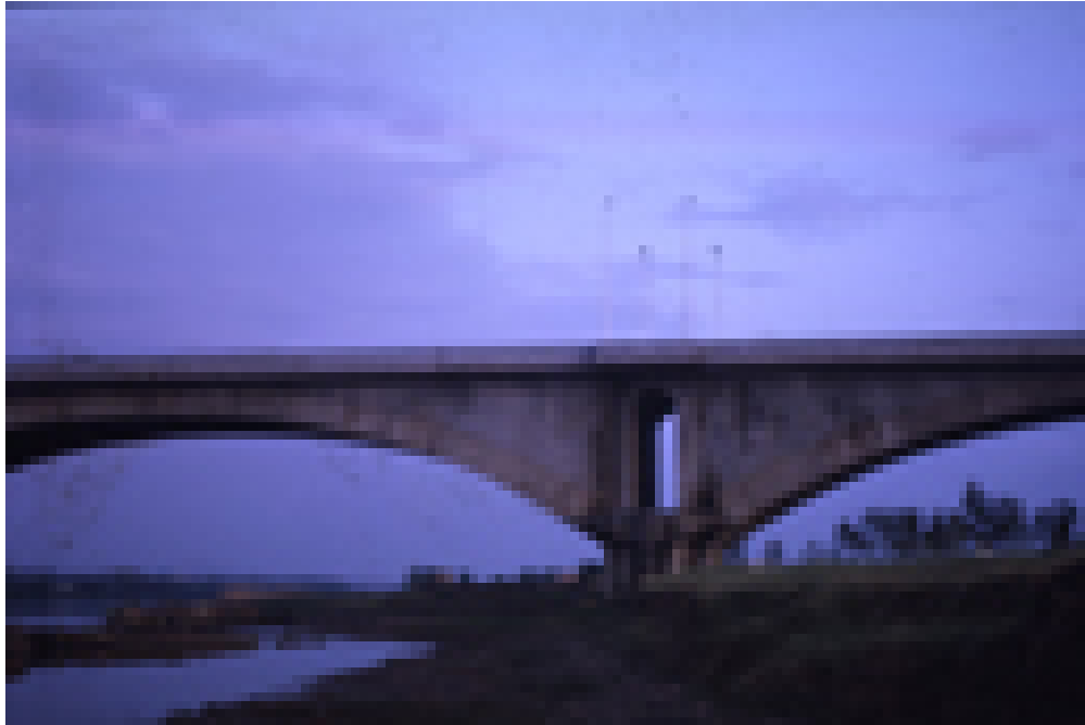
Detalle del puente
