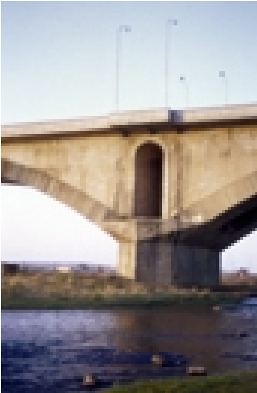
Detalle del puente
