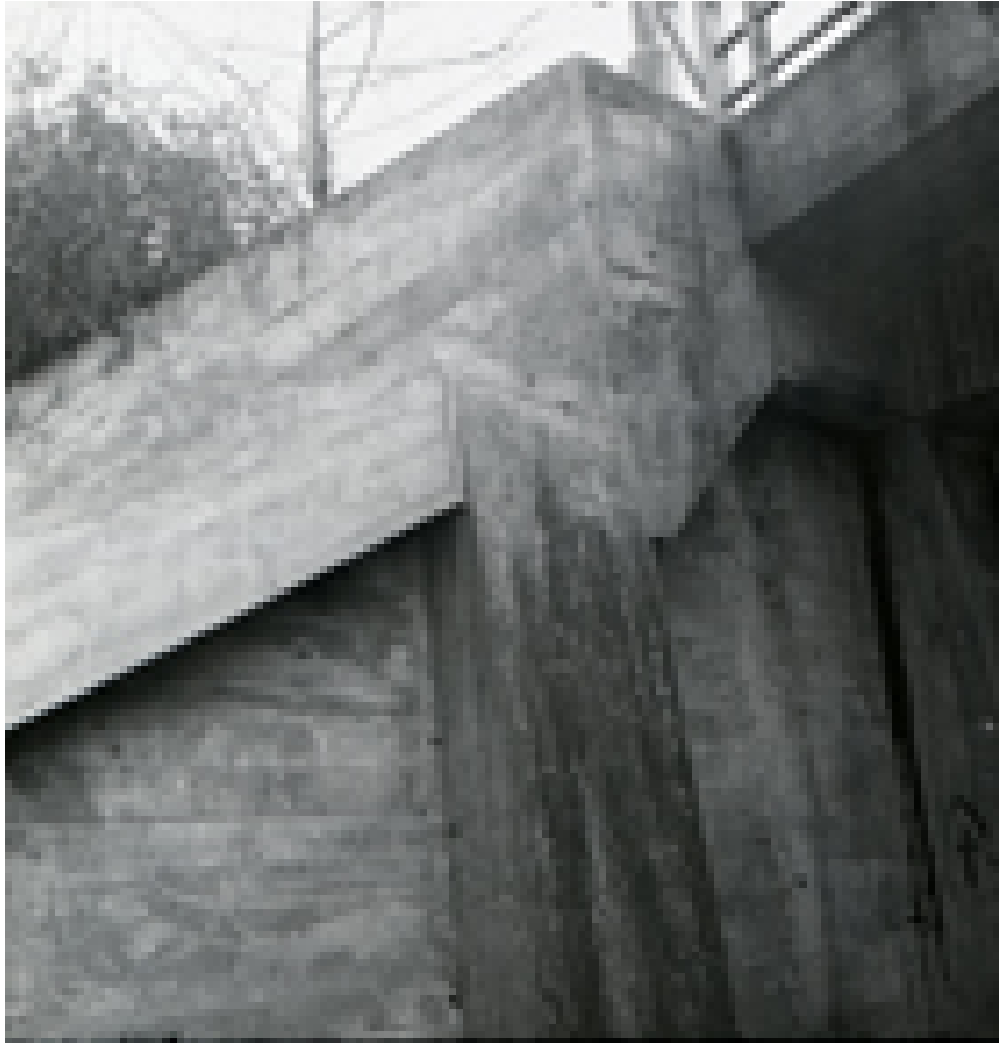
Detalle del puente
