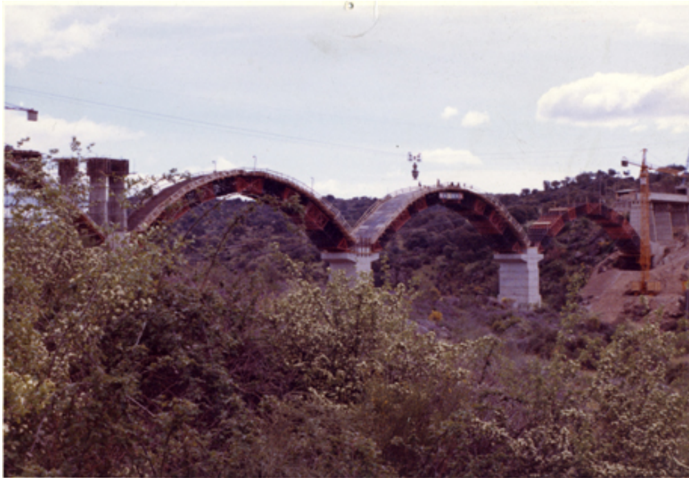
Construcción de los forjados de los arcos
