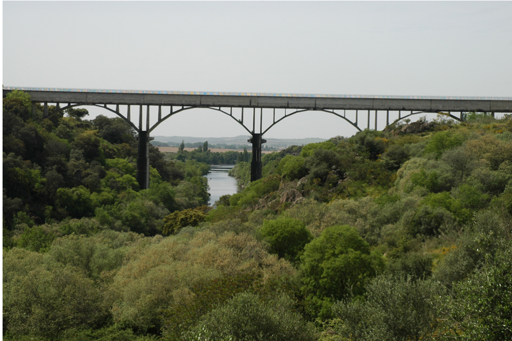
Vista del acueducto
