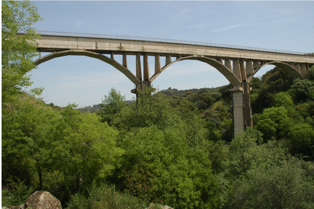
Vista del acueducto
