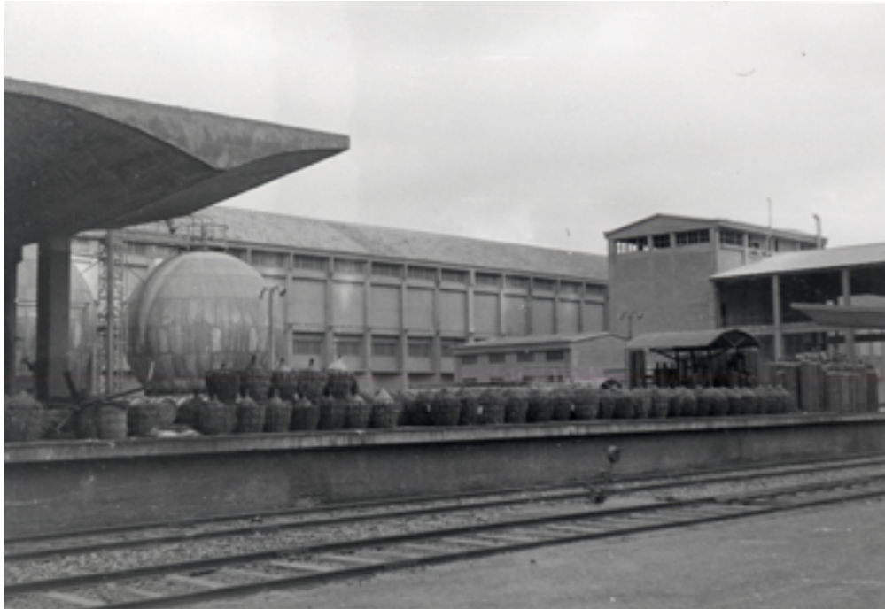
Detalle de las instalaciones
