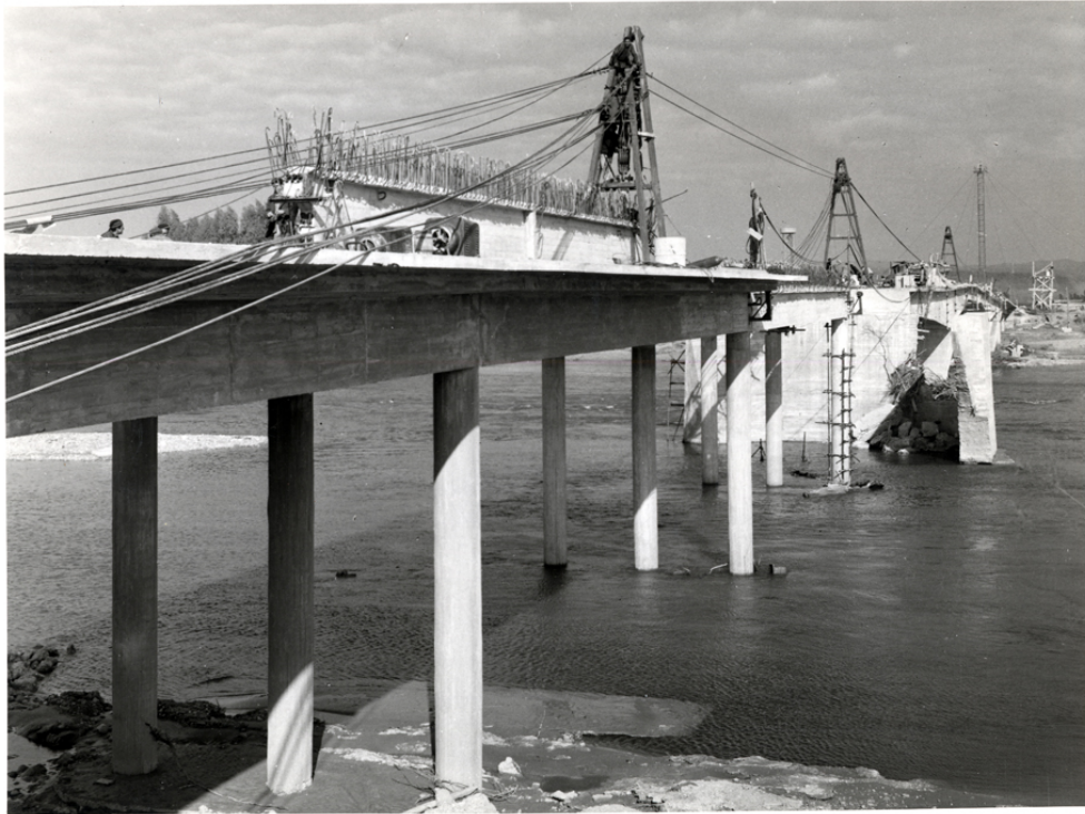
Perspectiva del puente en construcción
