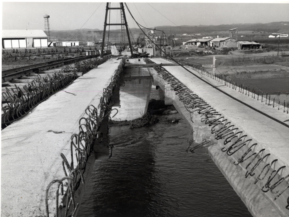
Detalle del puente en construcción
