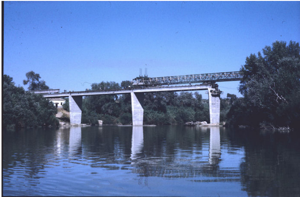
Vista del puente en construcción
