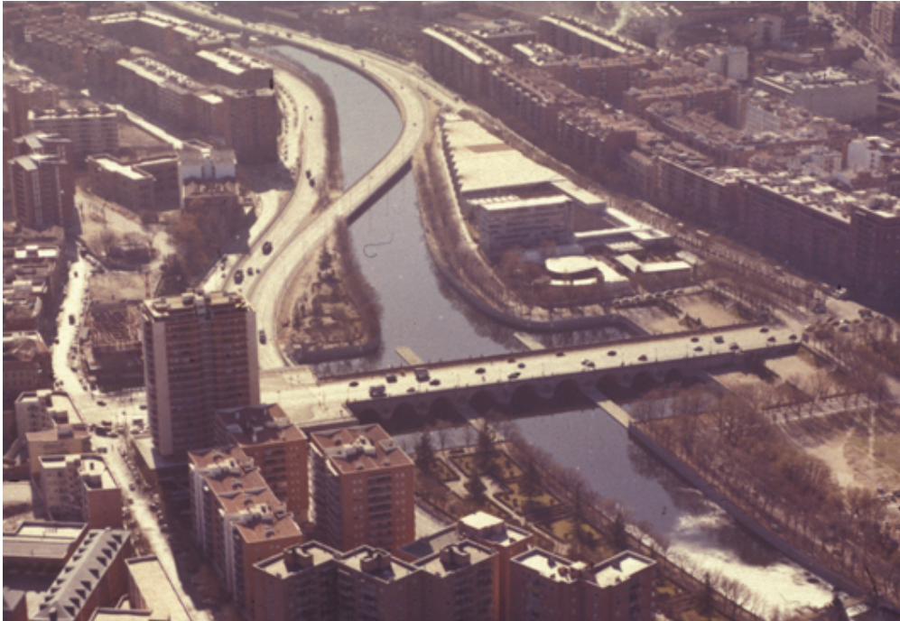
Vista aérea del puente
