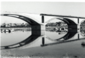
Id: I/FC-049/014 Título: Detalle del puente en construcción Dimensiones: 69 x 100 mm
