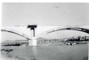
Id: I/FC-049/041 Título: Detalle del puente en construcción Dimensiones: 69 x 100 mm
