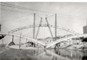
Id: I/FC-049/059 Título: Detalle del puente en construcción Dimensiones: 113 x 167 mm
