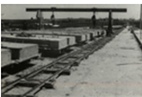
Id: I/FC-049/119 Título: Detalle del puente en construcción Dimensiones: 23 x 35 mm
