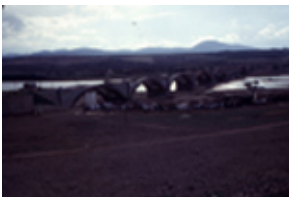
Id: I/FC-049/088 Título: Vista del puente en construcción Dimensiones: 23 x 35 mm
