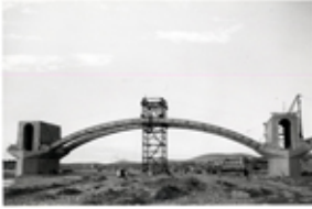
Id: I/FC-049/030 Título: Detalle del puente en construcción Dimensiones: 69 x 100 mm
