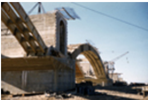
Id: I/FC-049/113 Título: Detalle del puente en construcción Dimensiones: 23 x 35 mm
