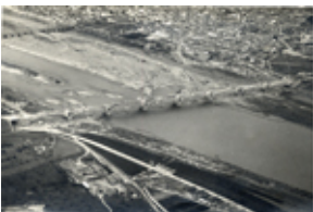
Id: I/FC-049/069 Título: Vista aérea del puente en construcción Dimensiones: 173 x 233 mm
