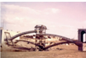
Id: I/FC-049/137 Título: Detalle del puente en construcción Dimensiones: 23 x 35 mm
