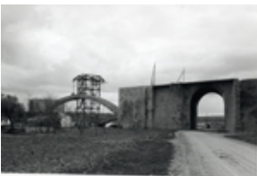
Id: I/FC-049/016 Título: Detalle del puente en construcción Dimensiones: 69 x 100 mm
