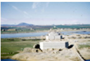
Id: I/FC-049/089 Título: Vista del puente en construcción Dimensiones: 23 x 35 mm
