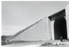
Id: I/FC-049/025 Título: Detalle del puente en construcción Dimensiones: 69 x 100 mm
