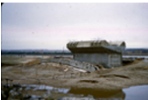
Id: I/FC-049/087 Título: Detalle del puente en construcción Dimensiones: 23 x 35 mm
