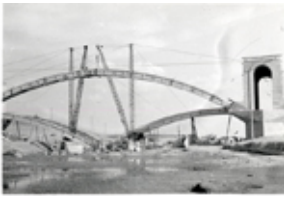
Id: I/FC-049/054 Título: Detalle del puente en construcción Dimensiones: 112 x 167 mm
