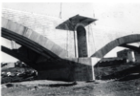
Id: I/FC-049/026 Título: Detalle del puente en construcción Dimensiones: 69 x 100 mm
