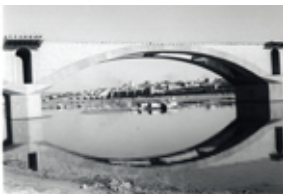
Id: I/FC-049/028 Título: Detalle del puente en construcción Dimensiones: 69 x 100 mm
