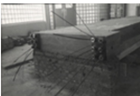
Id: I/FC-049/118 Título: Losa pretensada Dimensiones: 23 x 35 mm
