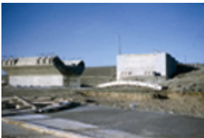
Id: I/FC-049/140 Título: Detalle del puente en construcción Dimensiones: 23 x 35 mm
