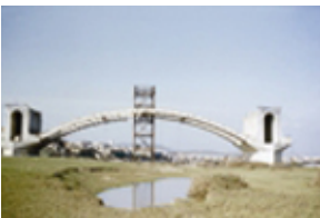
Id: I/FC-049/134 Título: Detalle del puente en construcción Dimensiones: 23 x 35 mm
