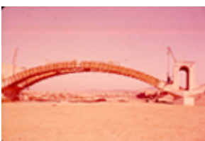
Id: I/FC-049/130 Título: Detalle del puente en construcción Dimensiones: 23 x 35 mm
