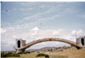
Id: I/FC-049/082 Título: Detalle del puente en construcción Dimensiones: 23 x 35 mm
