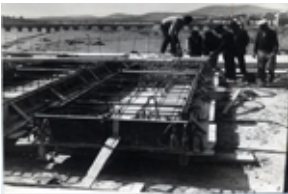
Id: I/FC-049/068 Título: Detalle del puente en construcción Dimensiones: 180 x 243 mm
