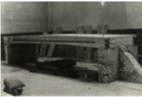
Id: I/FC-049/132 Título: Losa pretensada Dimensiones: 23 x 35 mm
