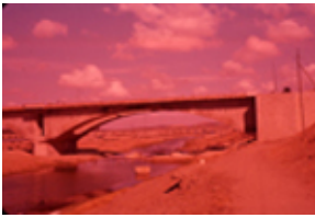
Id: I/FC-049/096 Título: Detalle del puente en construcción Dimensiones: 23 x 35 mm
