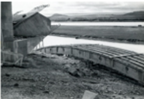
Id: I/FC-049/032 Título: Detalle del puente en construcción Dimensiones: 69 x 100 mm
