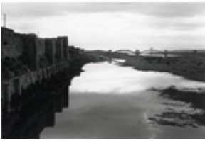
Id: I/FC-049/012 Título: Vista del puente en construcción Dimensiones: 69 x 100 mm
