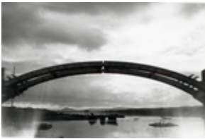
Id: I/FC-049/018 Título: Detalle del puente en construcción Dimensiones: 69 x 100 mm
