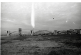
Id: I/FC-049/029 Título: Vista del puente en construcción Dimensiones: 69 x 100 mm
