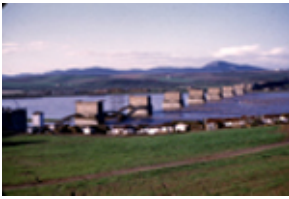
Id: I/FC-049/084 Título: Vista del puente en construcción Dimensiones: 23 x 35 mm
