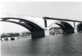
Id: I/FC-049/027 Título: Detalle del puente en construcción Dimensiones: 69 x 100 mm
