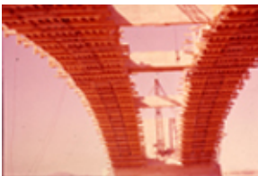
Id: I/FC-049/098 Título: Detalle del puente en construcción Dimensiones: 23 x 35 mm
