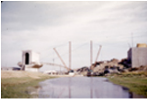
Id: I/FC-049/109 Título: Detalle del puente en construcción Dimensiones: 23 x 35 mm
