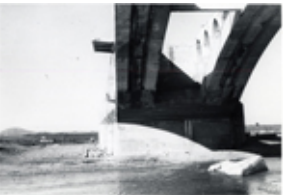
Id: I/FC-049/033 Título: Detalle del puente en construcción Dimensiones: 69 x 100 mm
