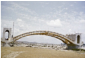
Id: I/FC-049/138 Título: Detalle del puente en construcción Dimensiones: 23 x 35 mm
