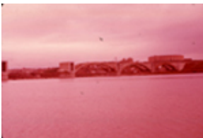
Id: I/FC-049/105 Título: Vista del puente en construcción Dimensiones: 23 x 35 mm
