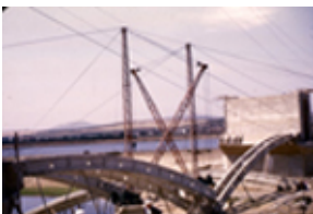
Id: I/FC-049/107 Título: Detalle del puente en construcción Dimensiones: 23 x 35 mm
