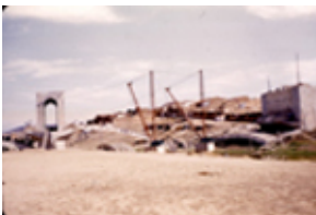
Id: I/FC-049/081 Título: Detalle del puente en construcción Dimensiones: 23 x 35 mm
