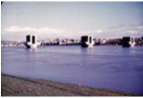
Id: I/FC-049/126 Título: Vista del puente en construcción Dimensiones: 23 x 35 mm
