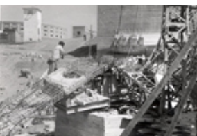
Id: I/FC-049/058 Título: Detalle del puente en construcción Dimensiones: 112 x 167 mm
