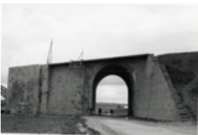
Id: I/FC-049/015 Título: Detalle del puente en construcción Dimensiones: 69 x 100 mm
