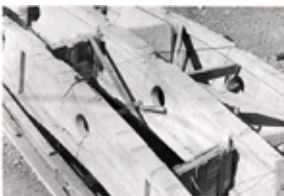
Id: I/FC-049/056 Título: Detalle del puente en construcción Dimensiones: 112 x 167 mm
