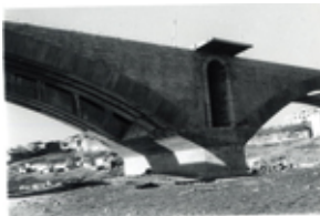
Id: I/FC-049/021 Título: Detalle del puente en construcción Dimensiones: 69 x 99 mm
