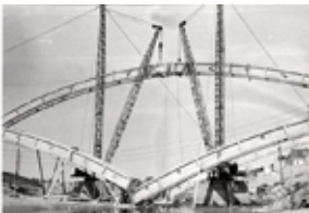
Id: I/FC-049/055 Título: Detalle del puente en construcción Dimensiones: 111 x 167 mm
