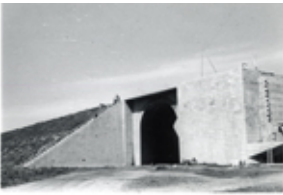
Id: I/FC-049/024 Título: Detalle del puente en construcción Dimensiones: 69 x 100 mm
