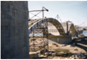
Id: I/FC-049/102 Título: Detalle del puente en construcción Dimensiones: 23 x 35 mm
