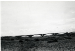
Id: I/FC-049/013 Título: Vista del puente en construcción Dimensiones: 69 x 100 mm
