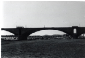
Id: I/FC-049/038 Título: Vista del puente en construcción Dimensiones: 69 x 100 mm
