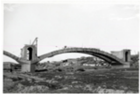
Id: I/FC-049/022 Título: Detalle del puente en construcción Dimensiones: 69 x 100 mm
