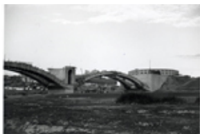
Id: I/FC-049/023 Título: Detalle del puente en construcción Dimensiones: 69 x 100 mm
