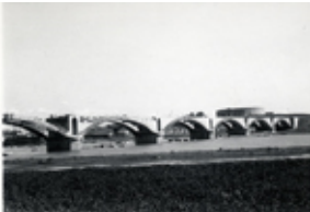
Id: I/FC-049/031 Título: Vista del puente en construcción Dimensiones: 69 x 100 mm
