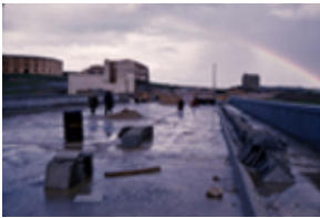
Id: I/FC-049/078 Título: Tablero del puente Dimensiones: 23 x 35 mm
