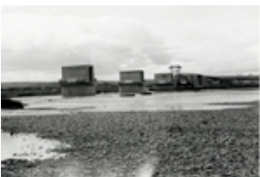
Id: I/FC-049/017 Título: Vista del puente en construcción Dimensiones: 69 x 100 mm
