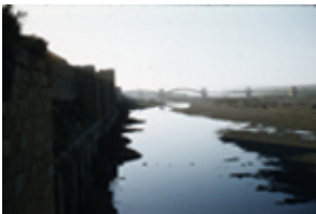
Id: I/FC-049/079 Título: Vista del puente en construcción Dimensiones: 23 x 35 mm
