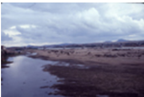
Id: I/FC-049/080 Título: Vista del puente en construcción Dimensiones: 23 x 35 mm
