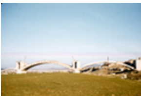
Id: I/FC-049/083 Título: Vista del puente en construcción Dimensiones: 23 x 35 mm
