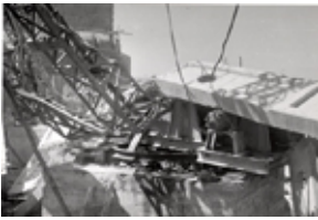
Id: I/FC-049/066 Título: Detalle del puente en construcción Dimensiones: 112 x 167mm
