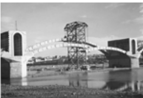
Id: I/FC-049/136 Título: Detalle del puente en construcción Dimensiones: 23 x 35 mm
