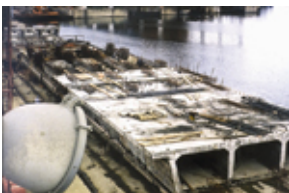
Id: I/FC-127/017 Título: Vista del puente en construcción
