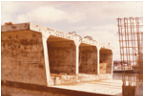
Id: I/FC-127/013 Título: Detalle del puente en construcción
