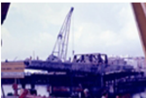
Id: I/FC-127/015 Título: Detalle del puente en construcción
