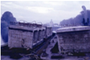
Id: I/FC-127/014 Título: Detalle del puente en construcción
