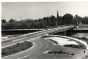
Id: I/FC-127/008 Título: Vista del puente y carretera Dimensiones: 119 x 179 mm
