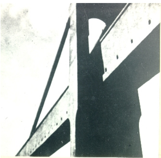
Id: I-ETM-002-16 Título: Acueducto de Tempul. Detalle 3 Fechas:
