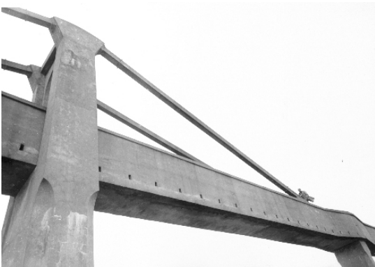
Id: I-ETM-002-10 Título: Acueducto de Tempul. Detalle.1 Fechas:
