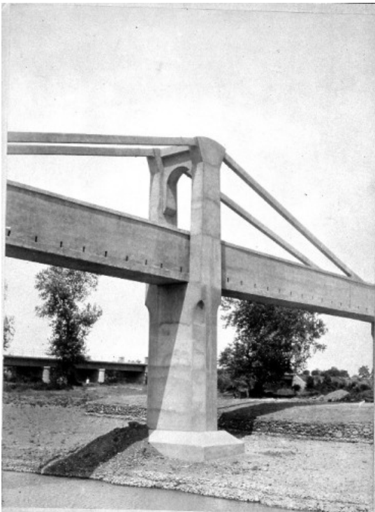
Id: I-ETM-002-F14 Título: Acueducto de Tempul. Detalle de una pila Fechas:
