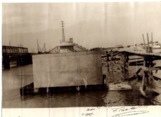
Id: I-ETM-018-05 Título: [Puente de Sancti Petri. Construcción. 4] Fechas: 1927
